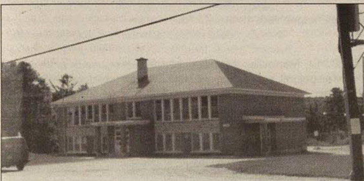
L'école centrale du village, Notre-Dame du Rosaire, construite en 1956 sur le terrain de l'ancienne salle paroissiale. Mme Madeleine Fournier en a été la directrice. Cette école devient l'hôtel de ville (La Communale) vers 1985.
