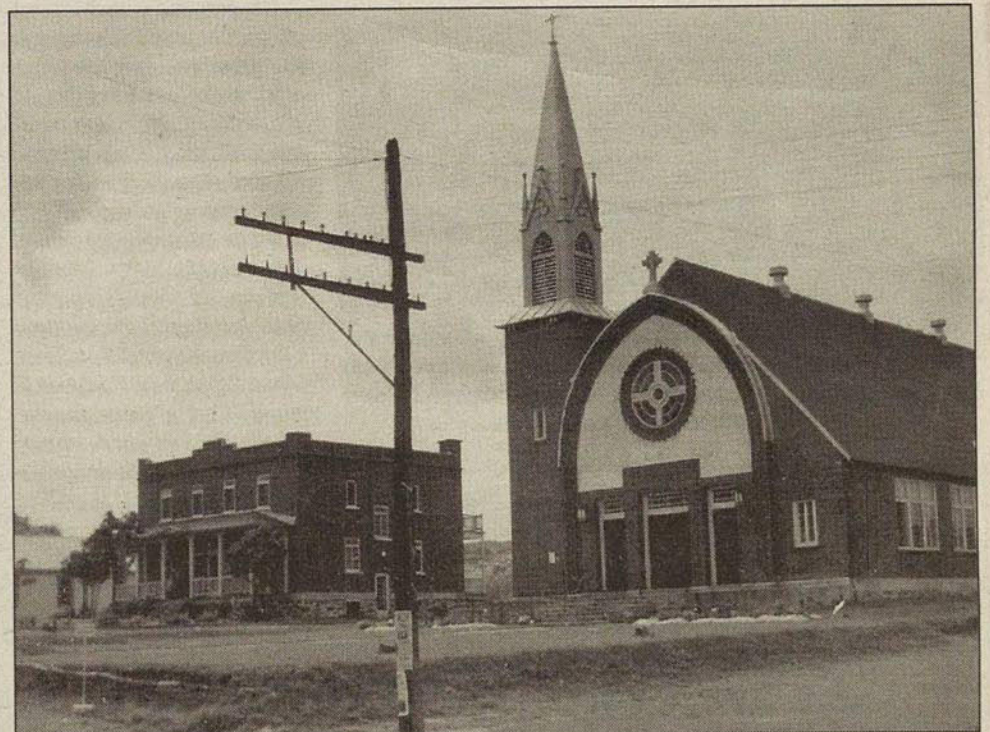
La nouvelle église, construite en 1933 et bénite par Mgr Gauthier le 26 novembre de la même année. En 1965, on adapta l'intérieur au renouveau liturgique. Elle fut consacrée par Mgr Valois le 14 août 1983.
